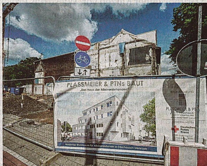
Im Juli 2025 feierte das Projekt in Oberhausen-Sterkrade Spatenstich.
