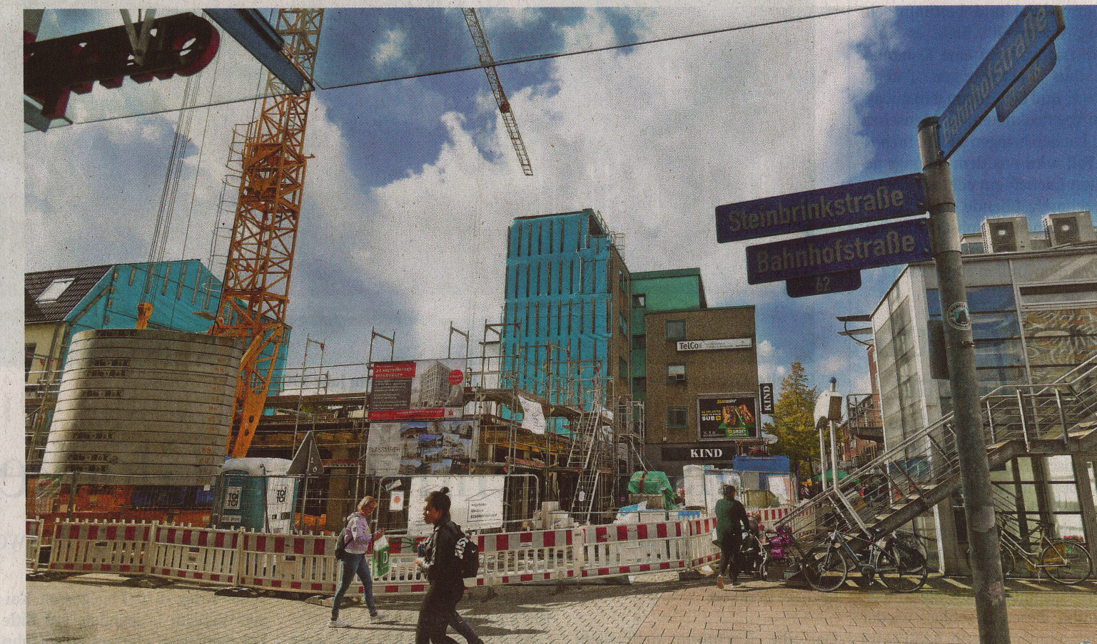
An der Ecke Steinbrink-/Bahnhofstraße in Sterkrade-Mitte kreist der Baukran.
