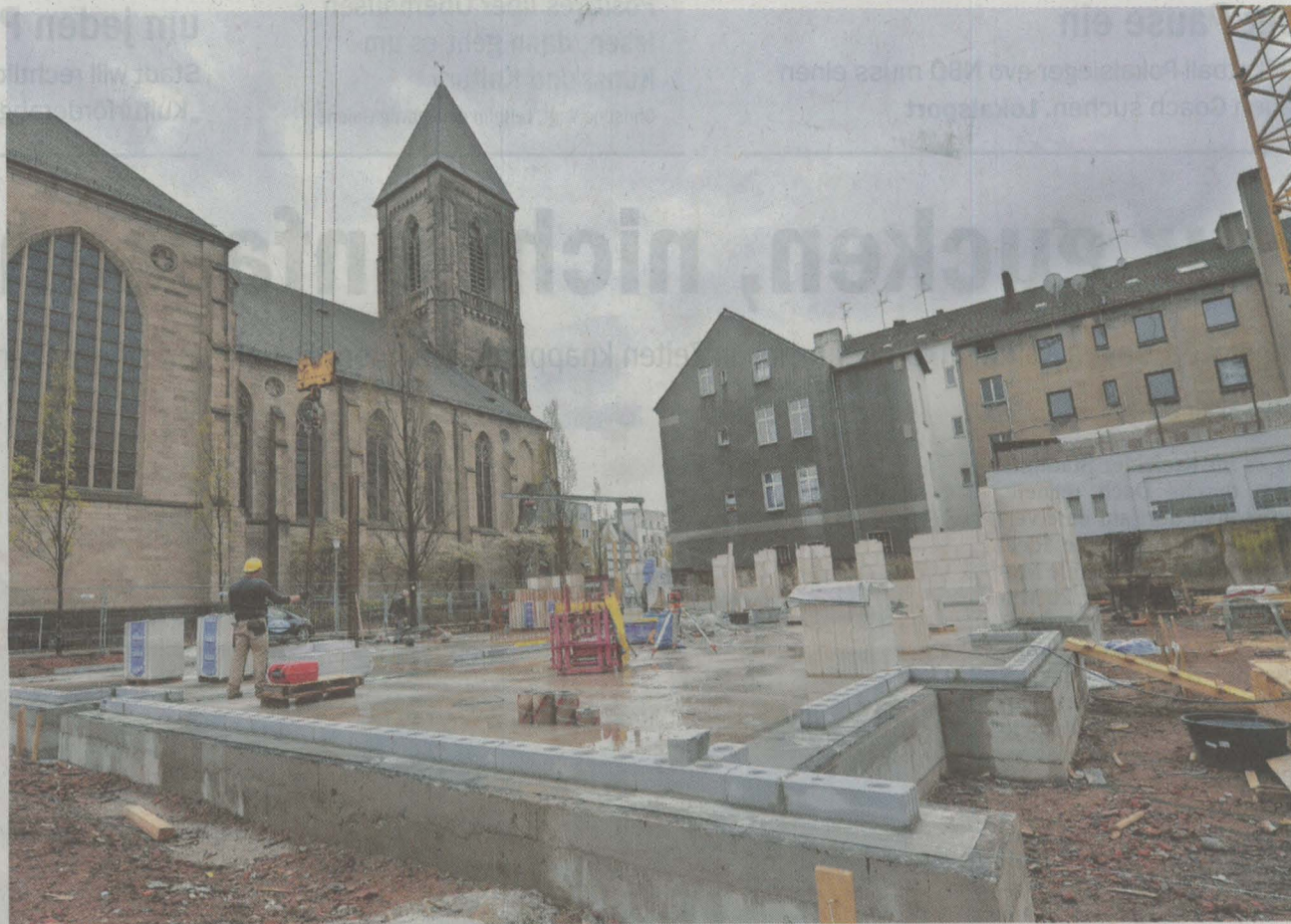
Kaum ist das Fundament des ersten Gebäudes gelegt, sind alle Wohnungen vermietet.
